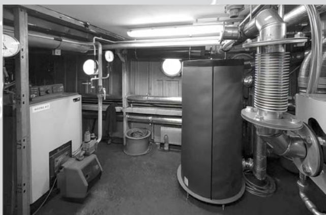
Instalace plynové kogenerační jednotky, kouřovodu s tlumičem hluku a komína v komínové šachtě | Hotel Admirál, Praha, Česká republika
