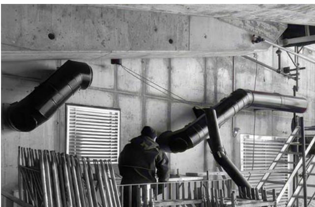
Instalace nerezového systému pro odvod spalin ze tří nouzových generátorů tepla | Klein Matterhorn (3 883 m n.m.), Švýcarsko
