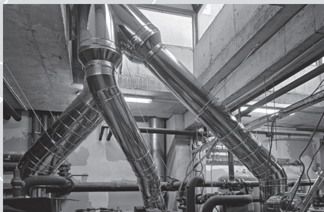
Instalace kotlů a dvou komínů DW25 v dětské pohotovostní nemocnici | Bukurešť, Rumunsko
