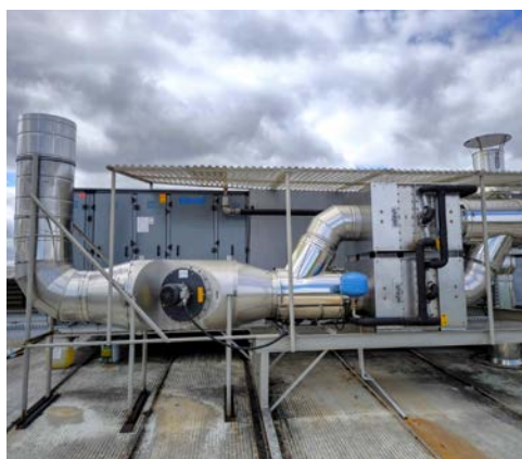
Instalace technologie na zpětné získávání tepla v sušičce zeleniny | Polsko
