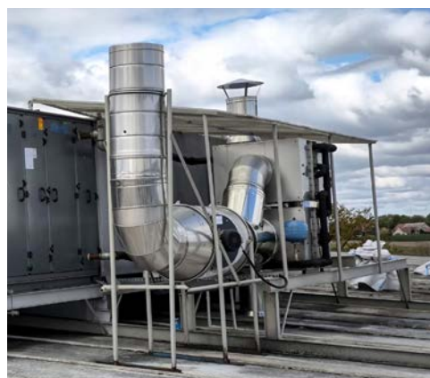
Instalace technologie na zpětné získávání tepla v sušičce zeleniny | Polsko
