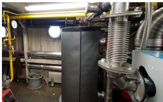
Instalace plynové kogenerační jednotky, kouřovodu s tlumičem hluku a komína v komínové šachtě | Hotel Admirál, Praha, Česká republika
