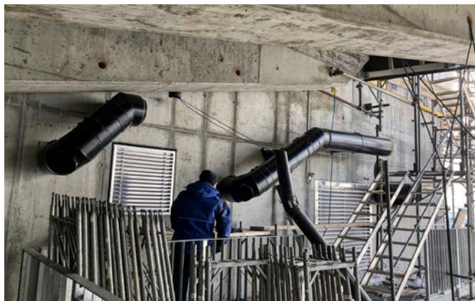
Instalace nerezového systému pro odvod spalin ze tří nouzových generátorů tepla | Klein Matterhorn (3 883 m n.m.), Švýcarsko
